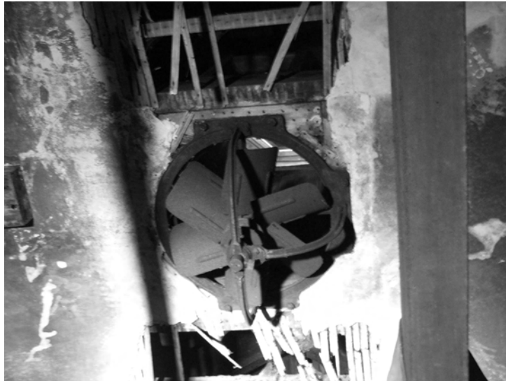
Plate 44 - Fan below louvred vent in E9
