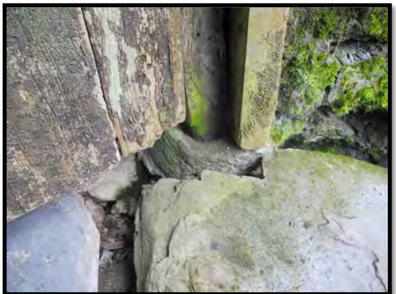
Plate 5: Harr Hung door & socket
