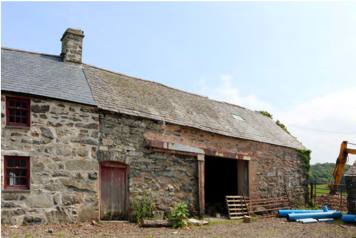
Barn (building B) SH 7923 6746
